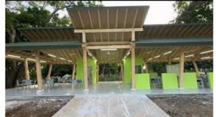
CONSTRUCCIÓN DE ZONA DE ESTUDIO - SAHAGÚN
