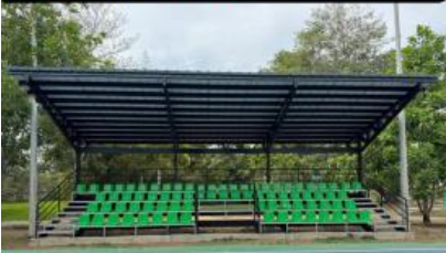
CONSTRUCCIÓN DE GRADERÍA METÁLICA - SAHAGÚN
