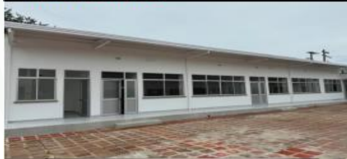
RECONSTRUCCIÓN DEL BLOQUE N° 1 - MONTELIBANO.
